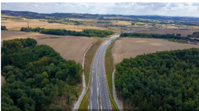
Dálnice D3 v úseku 0308C Veselí nad Lužnicí – Bošilec
