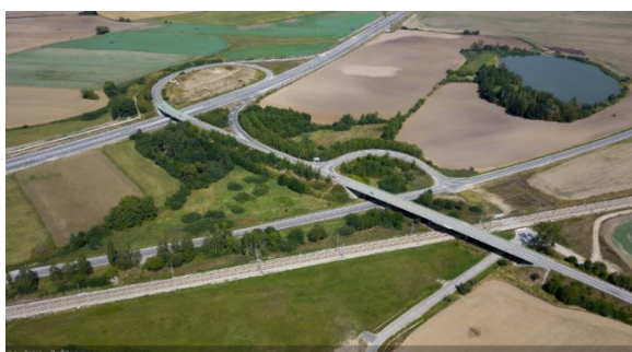
Dálnice D3 v úseku 0309/III Borek – Úsilné
