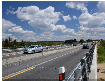
Modernizace dálnice D1 úsek 18, EXIT 134 Měřín - EXIT 141 Velké Meziříčí
